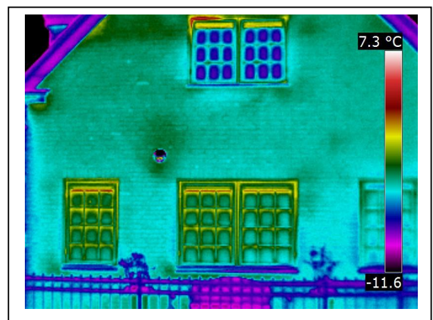
Woning waarbij enkel glas op de 1 ste verdieping is vervangen door HR-glas
